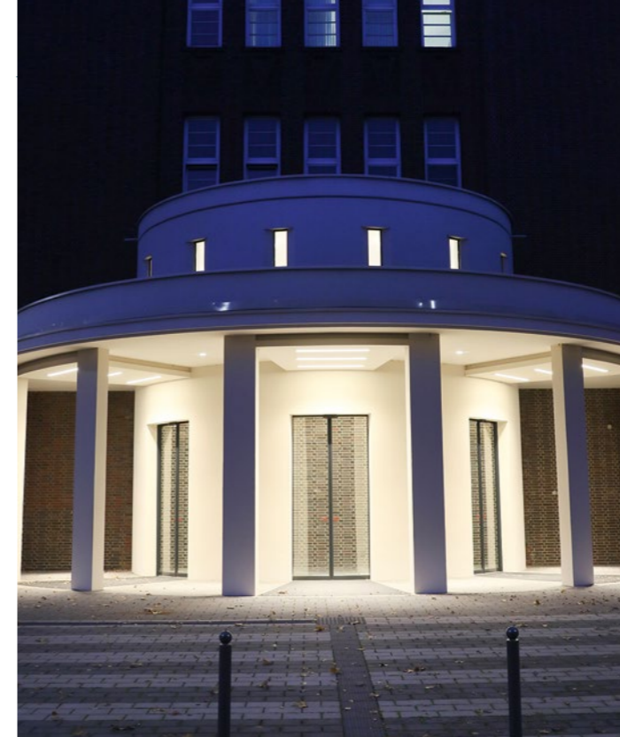
Seit Ende Oktober ist der neue Haupteingang geöffnet.
