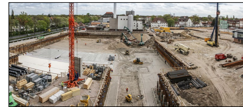
„Ausgrabungsstätte“ Bismarckstraße: Die Baugrube für das neue Klinikum wird ausgehoben.
